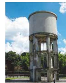
飛行場は台地にあるので水の確保に苦労しました。町の麓を流れる思い川から取水しポンプアップして高架式のタンクに貯水しました。戦時中は真っ直ぐ立っていましたが、地盤が悪かったため現在ではピサの斜塔のように少し傾いています。高さは約13m、直径は約6mあります。
