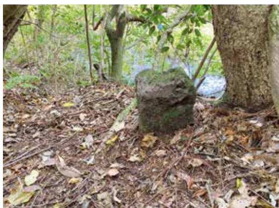
写真9 上部が欠損したとみられる境界標柱 (1)
