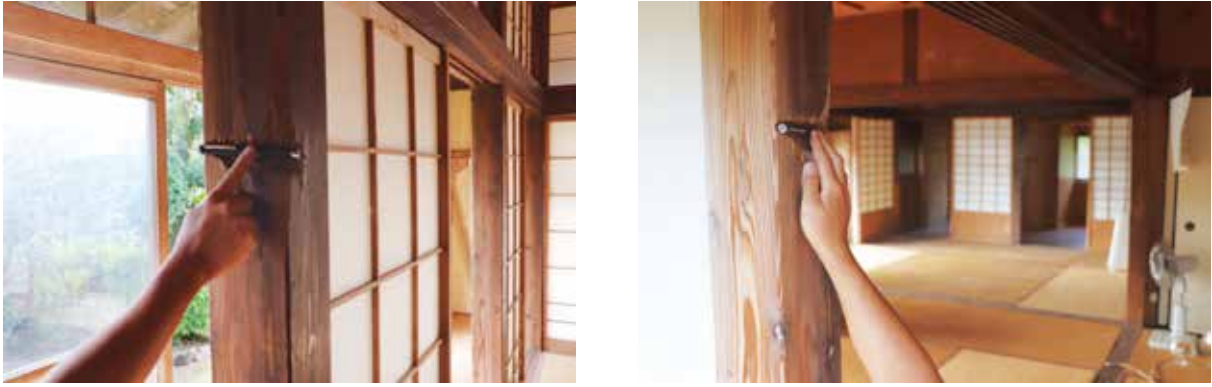
図6 江平家住宅内柱 調査風景（レーザーポインター使用）
